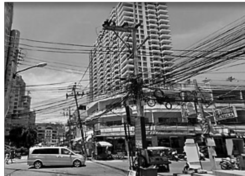
Рис. 2. Внешний вид опоры линий электропередач в Паттайе (Таиланд).
